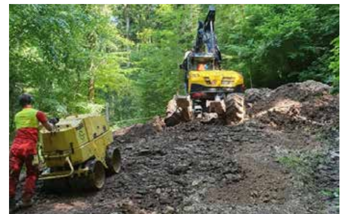
Vollständig mit lehmhaltiger Erde, welche verdichtet wird, abgedeckte Holzkastenkonstruktion.
