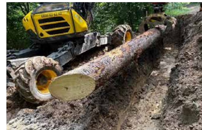
Einlegen der Grundschwelle
