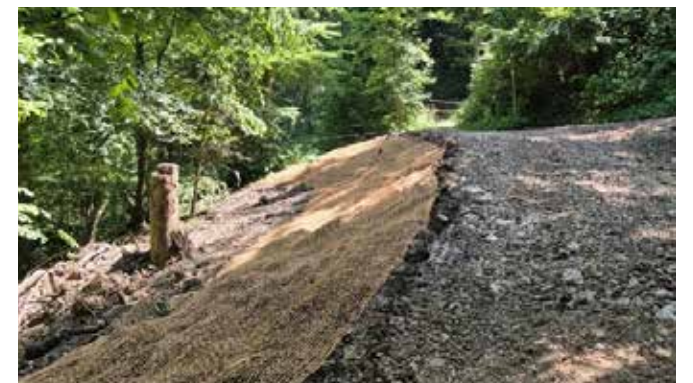
Die neu entstandene Böschung wird, um der Erosion vorzubeugen, mit einem Jutegewebe abgedeckt. In diese werden Weidenstecklinge gepflanzt.
