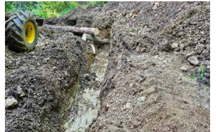
Vorbereitung der zweiten Grundschwelle, welche mit dem ersten Kasten verbunden wird
