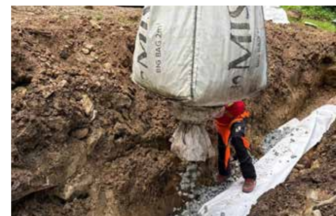
Die Sickerleitung wird mit Glassteinen abgedeckt
