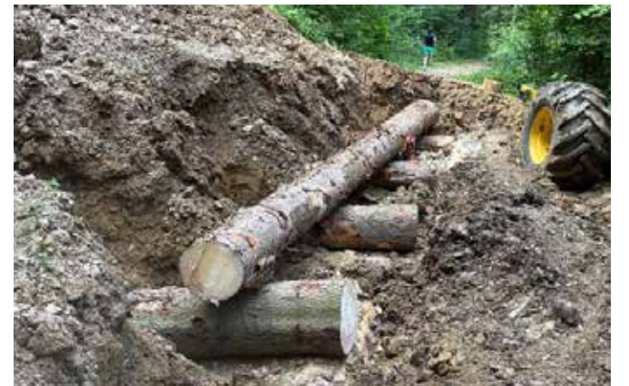
Einlegen der zweiten Schwelle auf die Zangen
